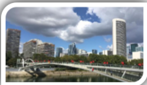
Passerelle de Puteaux
